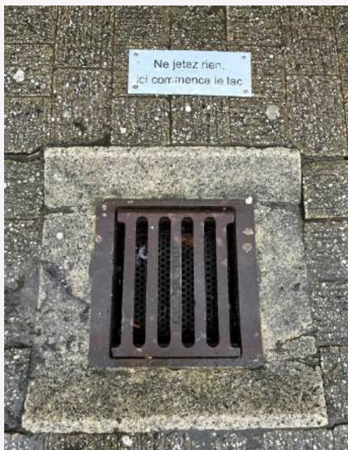
Avaloir du piétonnier (centre-ville)
